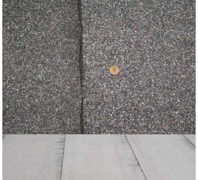
7 pav. Pro siūlę pratekėjusi polimerinė – bituminė masė (palyginimui – 10 centų moneta.)
