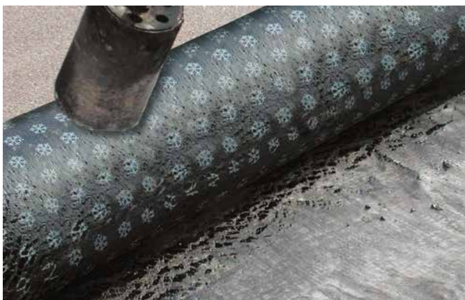
5 pav. Piešinio deformacija apatinėje ritinio pusėje, teisingai kaitinant paviršių
