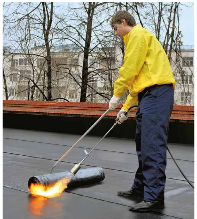
4 pav. Stogdengio padėtis dengiant stogą
